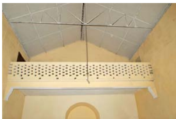
Opravený interiér kostela.
