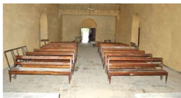
Interiér kostela při probíhající opravě.
