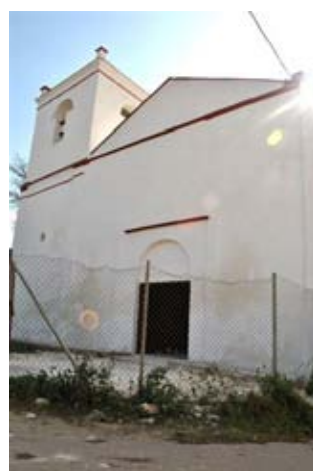
Exteriér kostela po opravě.
