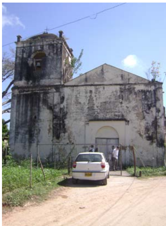
Kostel před opravou v roce 2014.
